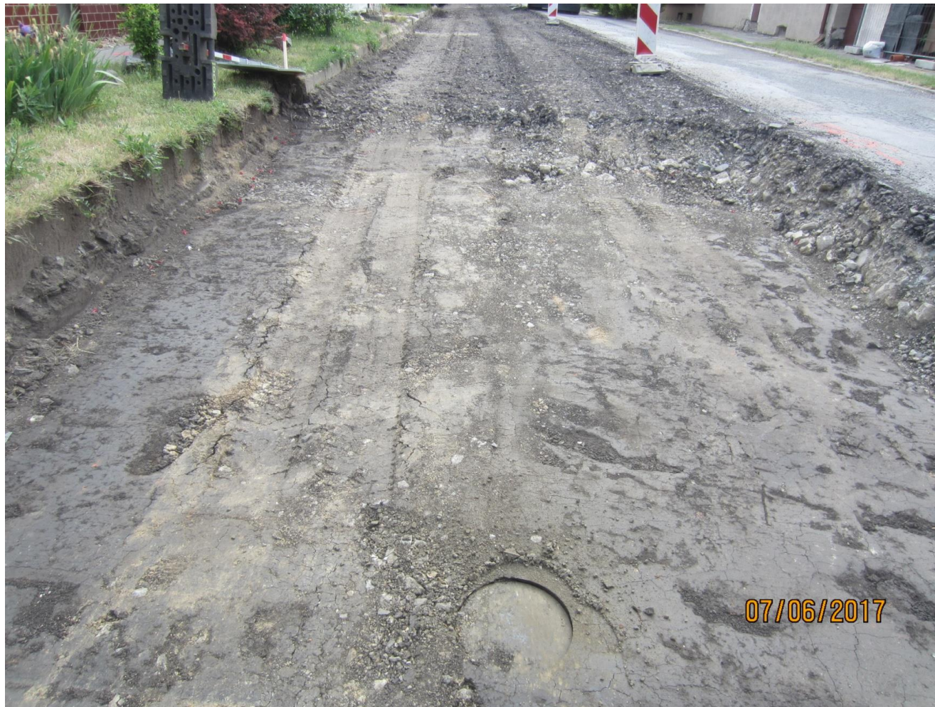
Stav pláně po odtěžení stávajících konstrukčních vrstev
