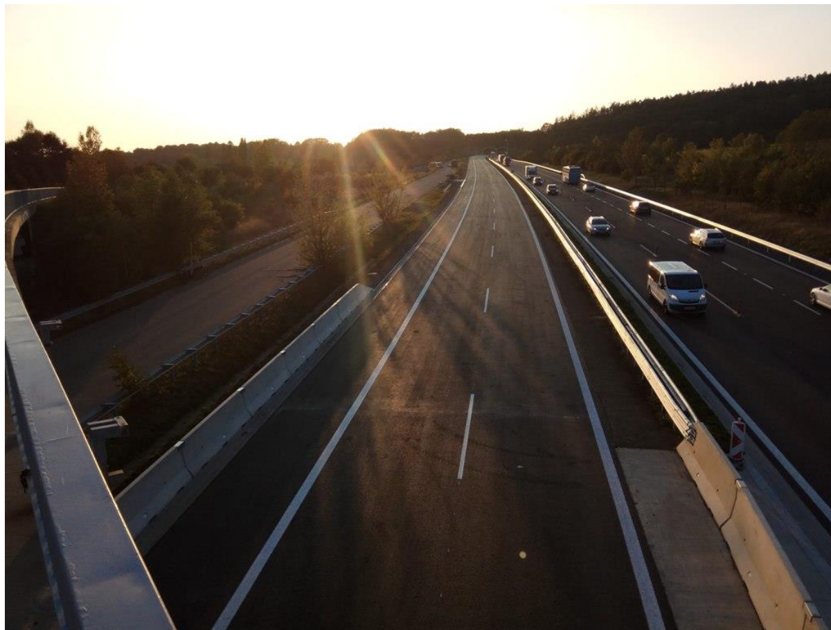
Rekonstruovaný úsek před uvedením do provozu
