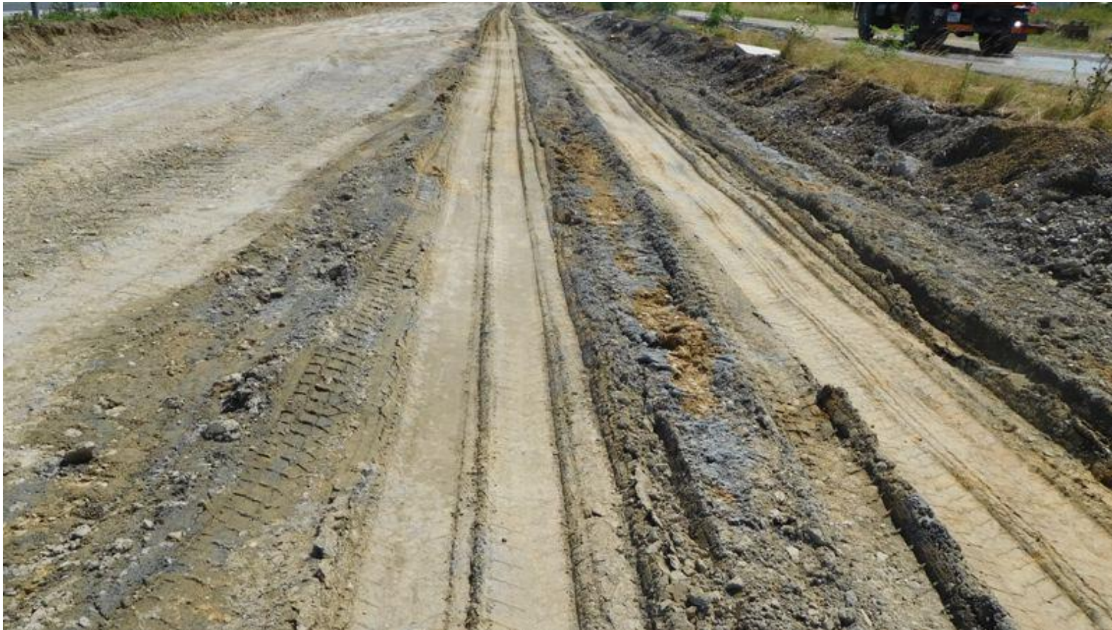
Povrch stávající pláně po odtěžení konstrukčních vrstev.
