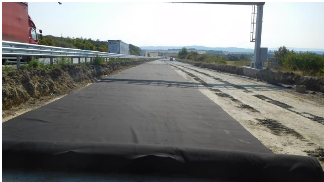
Pokládka geotextílie v úrovni parapláně
