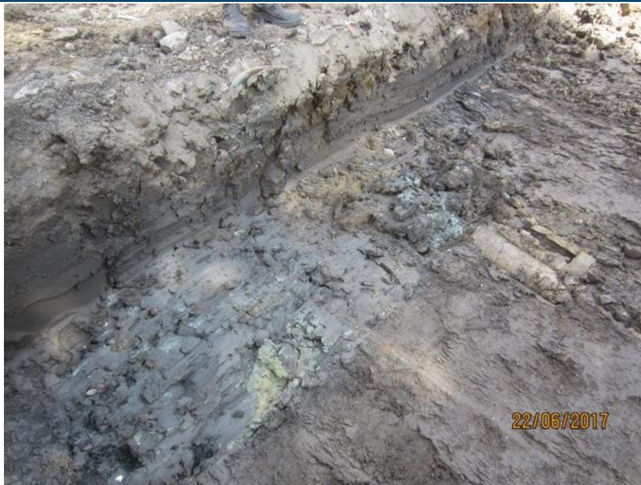
Materiál parapláně před rozprostřením geotextílie.
