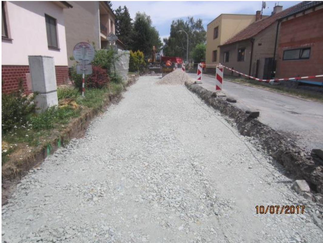
Pláň po provedené výměně materiálu AZ
