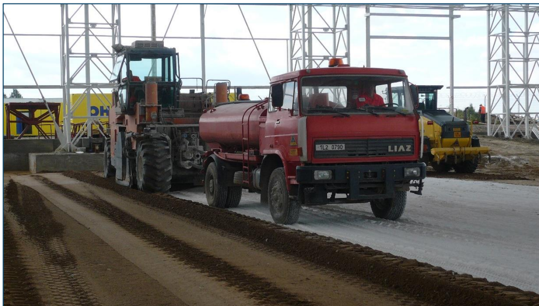
Stabilizace zemin kontaktního podloží podlahy hangáru (2007).
