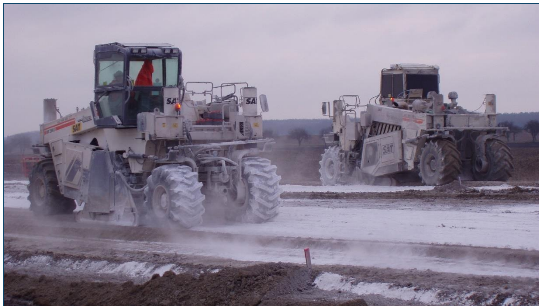
Zlepšení zemin podloží násypu vápnem. Dálnice D11 (2002).
