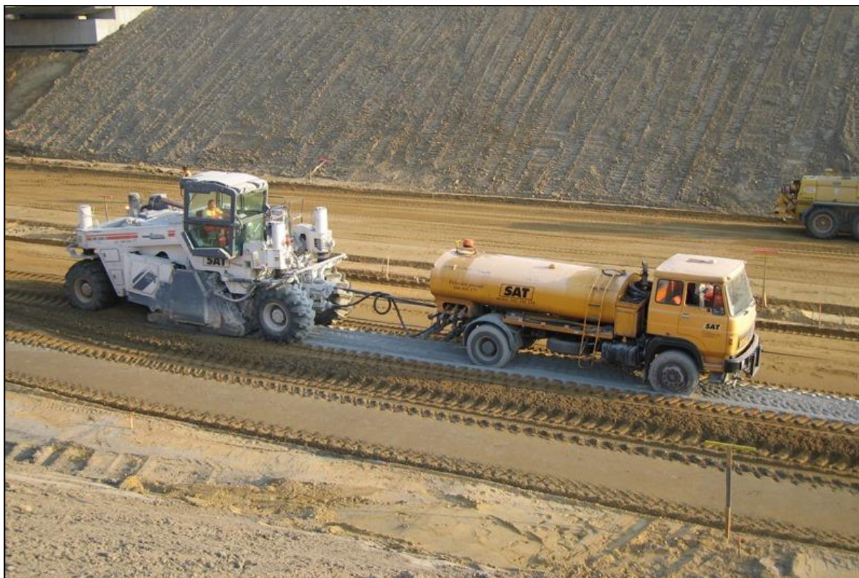
Obr.15 Stabilizace fluviatilních písků v aktivní zóně tuhé vozovky na stavbě 4707 (D1) v roce 2006
