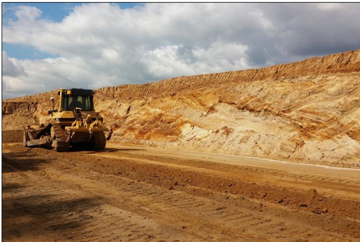
Obr.2 Zářez ve 12. km trasy silnice I/11 - Prodloužená Rudná
