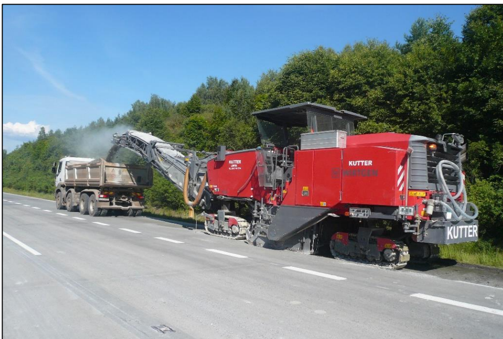
Obrázek 3: Frézování CB krytu (foto J. Havelka, 2020)
