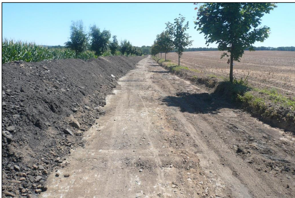
Obrázek 7: Stav pracovní pláně po skrytí konstrukčních vrstev (foto J. Havelka, 2020)
