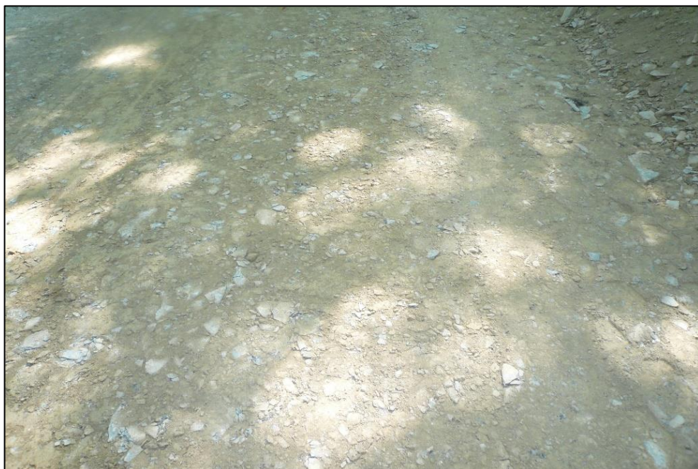
Obrázek 9: Povrch zemní pláňě po stabilizaci zemin aktivní zóny (foto J. Havelka, 2020)
