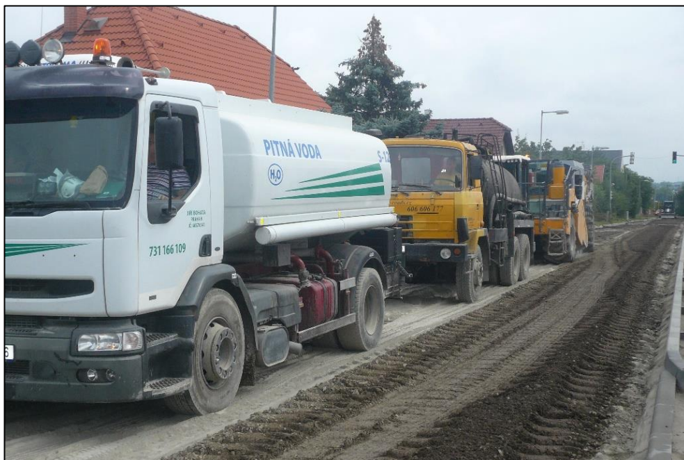
Obrázek 10: Tandemová sestava strojů pro studenou recyklaci (foto J. Havelka, 2020)
