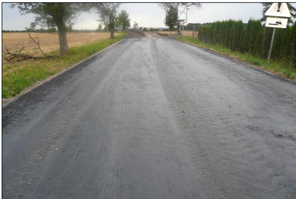
Obrázek 11: Infiltrační postřik na recyklované podkladní vrstvě (foto J. Havelka, 2020)
