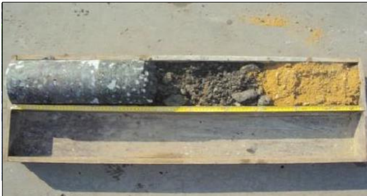
Obrázek 5: Vývrt v km 130,700 P (foto Viakontrol, 2018)
