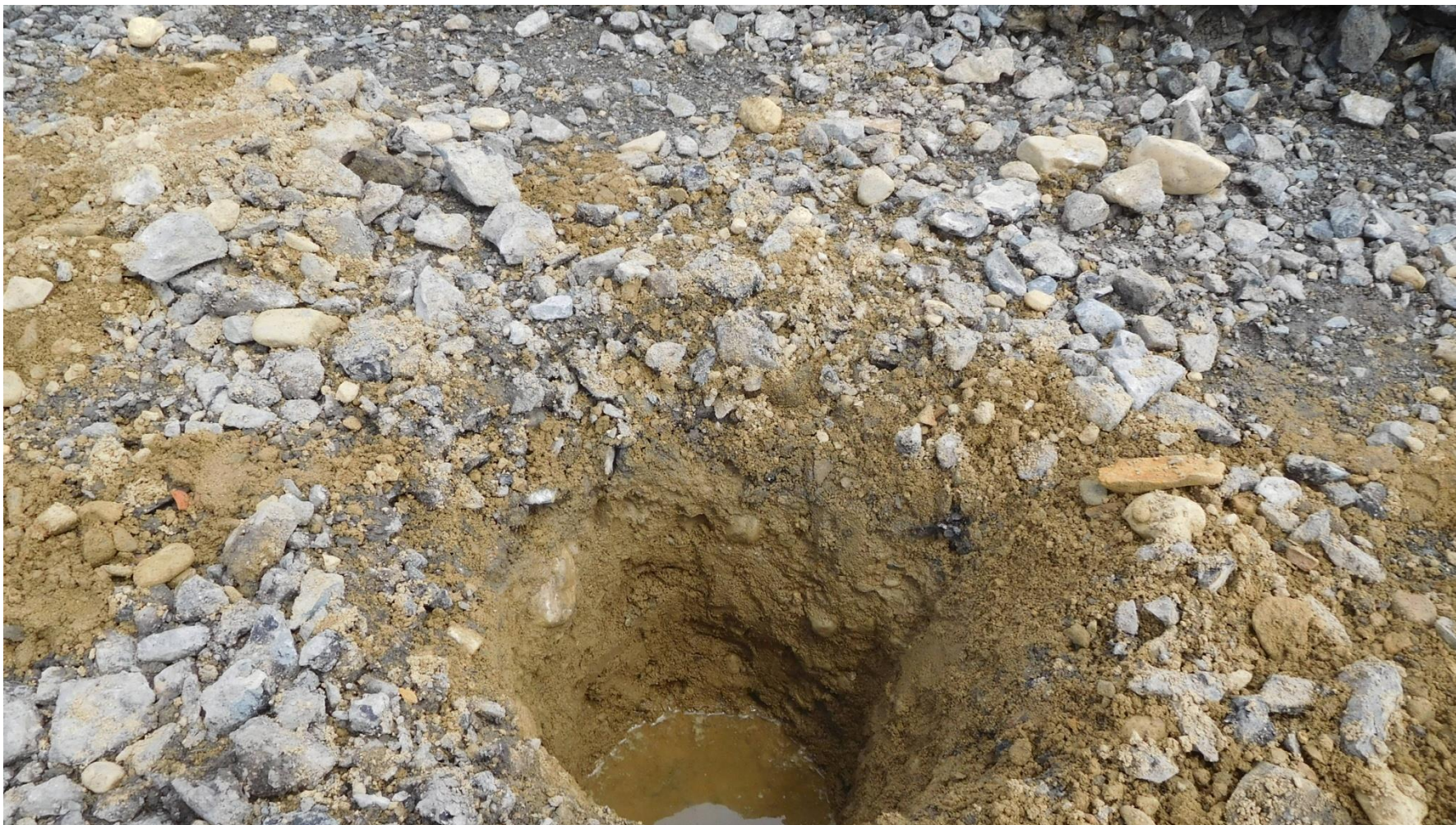
Místo č.2: Kopaná sonda do podloží po odfrézování cca 200 mm AHV. Hladina vody byla zastižena v hloubce 740 mm pod niveletou vozovky na násypu.
