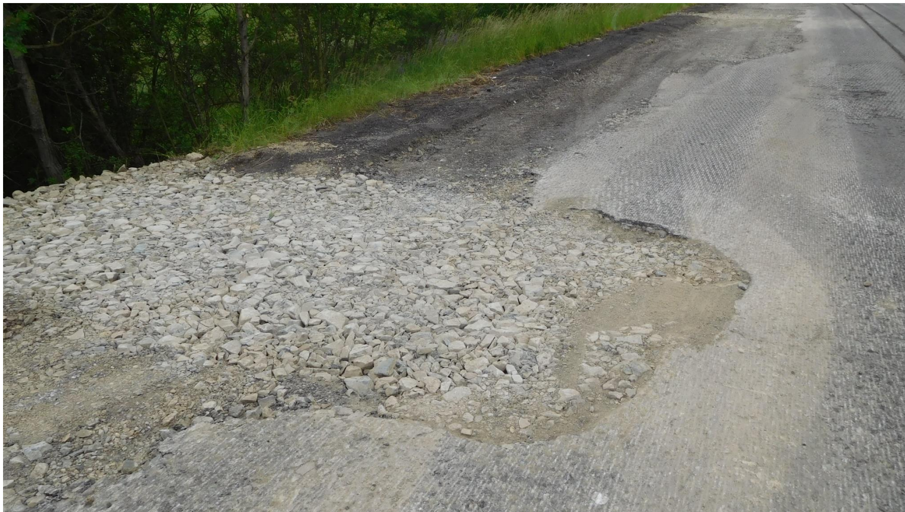
Místo č.1: Realizace odvodňovacího péra s vyvedením odtoku až na samotný svah násypu.
