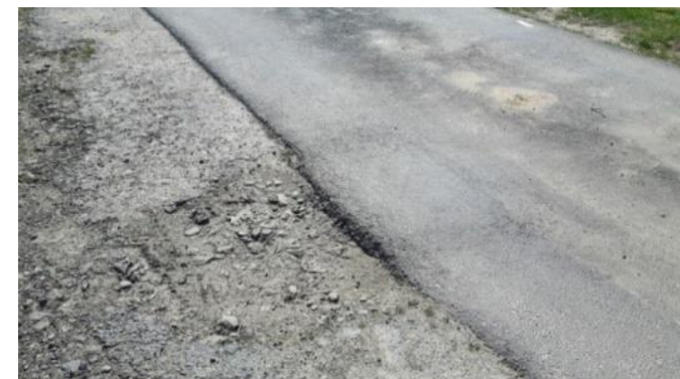
nerovný povrch a nedostatečné hutnění po stranách hrbu
